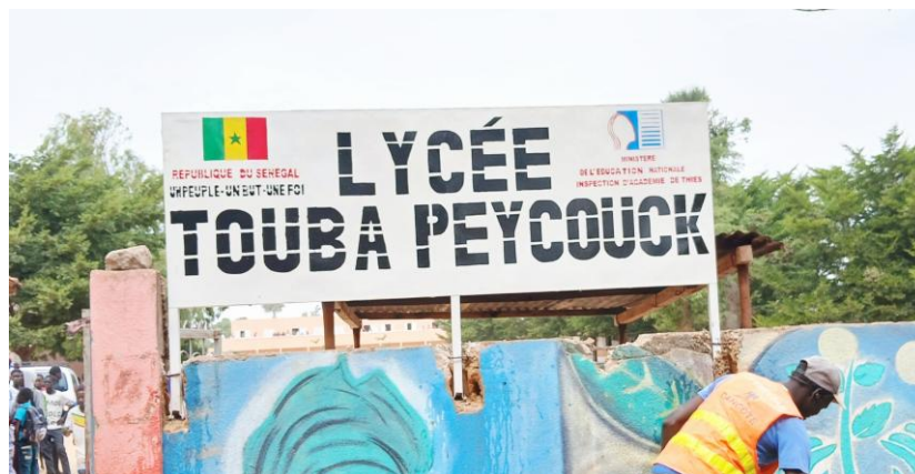
L'installation du panneau qui officialise l'existence du lycée de Peycouck
