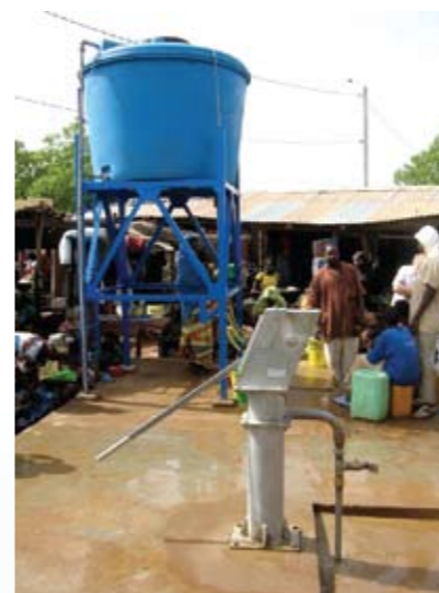
Pompe à motricité humaine installée en 2009. Origine du matériel : groupe Vergnet, Saran (45) En savoir plus : www.vergnet.fr
