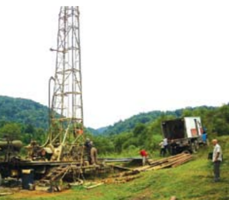
Réalisation du forage profond.
