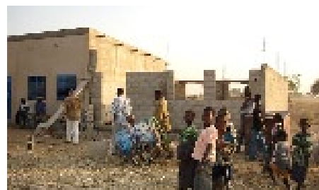
Construction d'une classe à Bané
